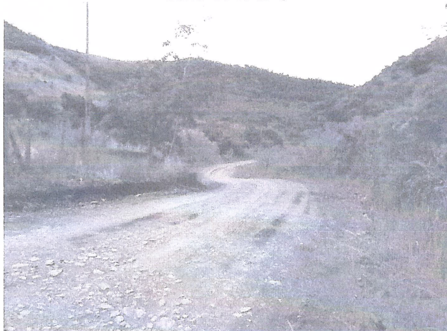
FOTO - N°09 LAT=26°02'13 "S LONG=51°58'49" O
