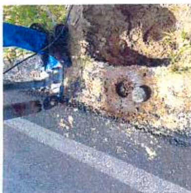
Sondagem Rotativa para Verificação de Espessura.
